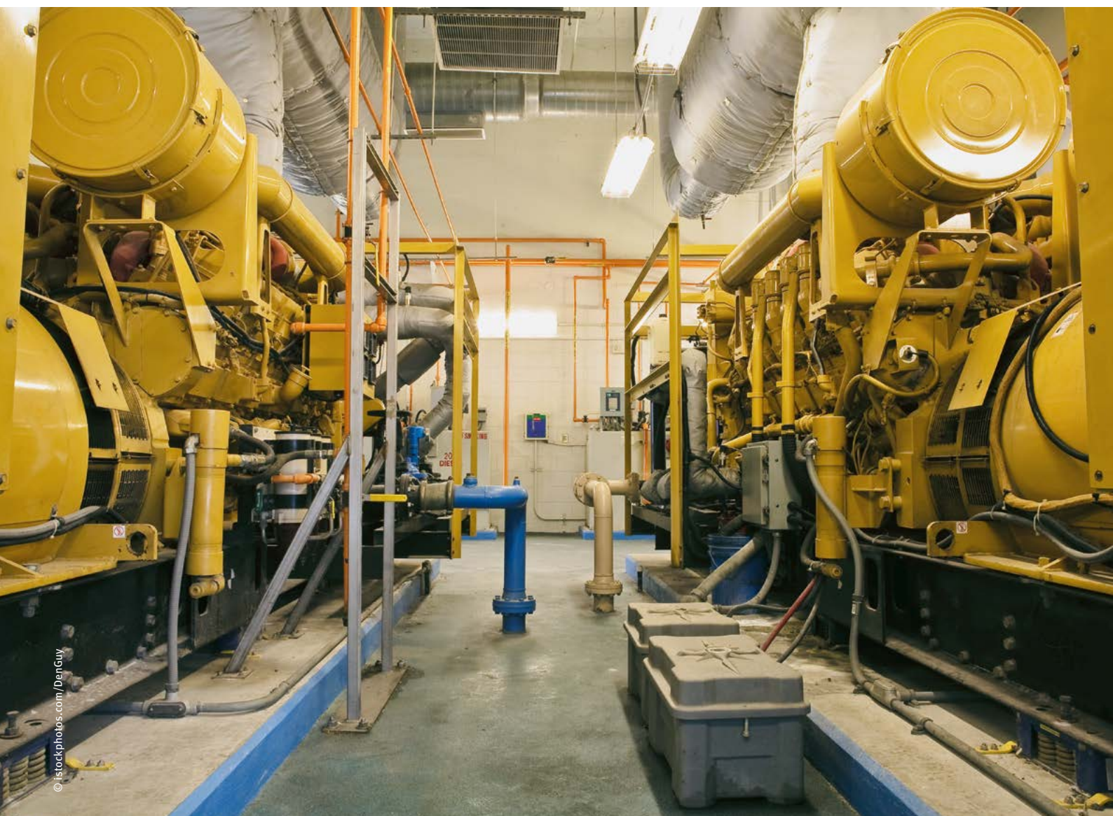
Les groupes électrogènes de secours fixes contribuent à garantir l'alimentation électrique en hiver
